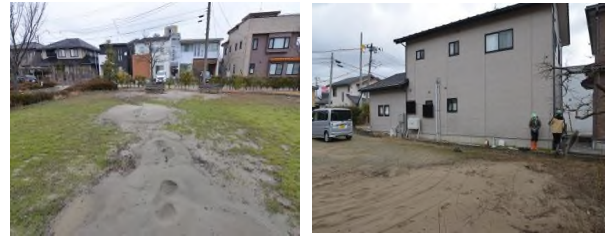
写真-1 ときめき西の噴砂 写真-2 善久のめり込み沈下
