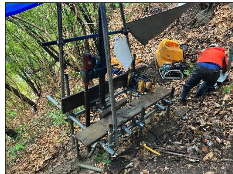
図-1 軽量型ボーリングマシン(電動型)の足場状況
