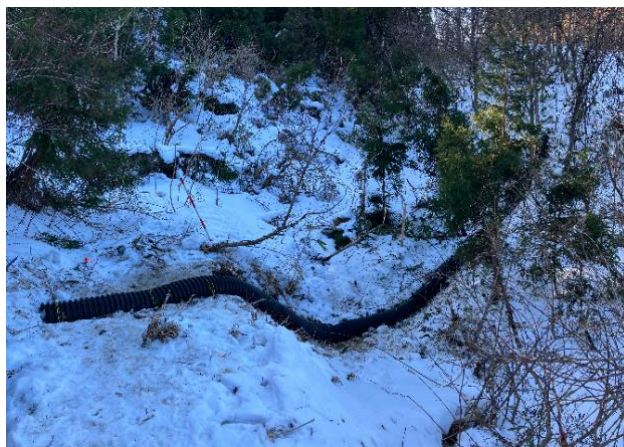
図-3 半割れ管の設置状況
