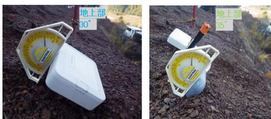
写真-3 変状状況(左:機器A、右:機器B)
