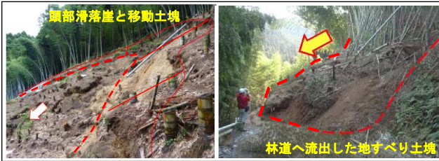
図-1 被害状況(H24 撮影)
