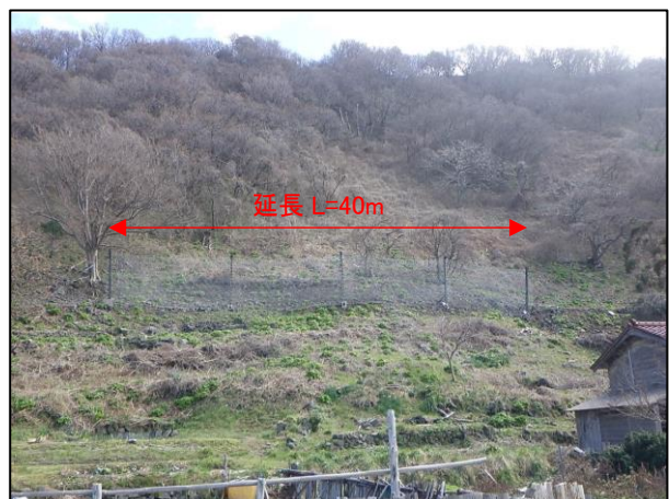
写真-4 高エネルギー吸収型落石防護柵工施工状況
