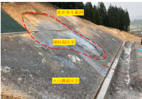
写真-1 崩壊発生前ののり面状況
