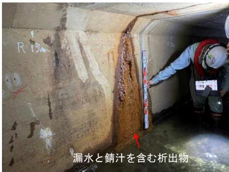
図-1 目視点検時状況写真
