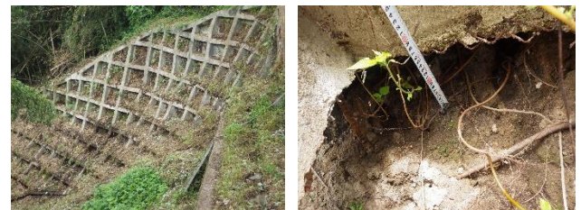
写真-1 法枠工遠景
