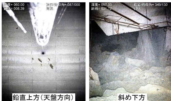
写真-2 空洞内部の写真撮影事例
