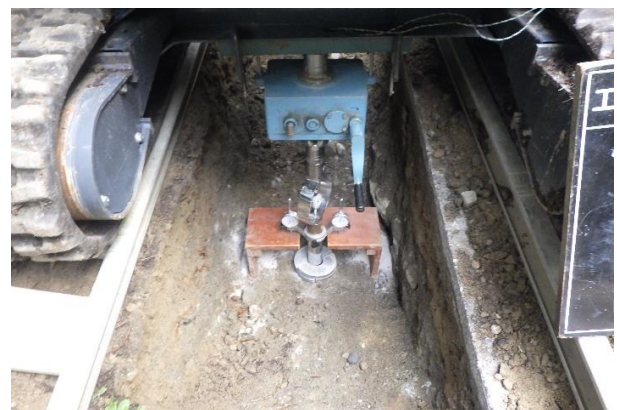
写真-1 現場 CBR 試験実施状況及び路床部の土質
