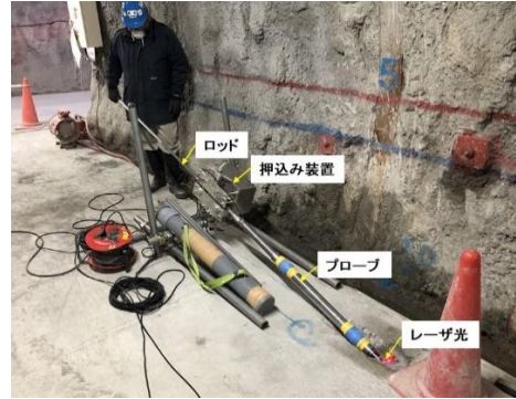
写真-1 測定状況写真
