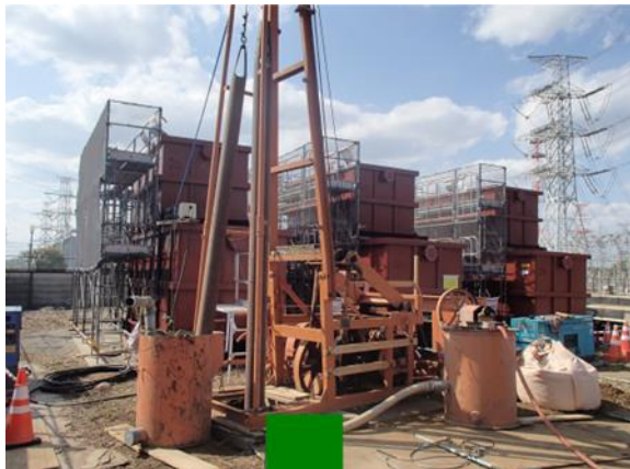
図-1 パーカッション工法全景
