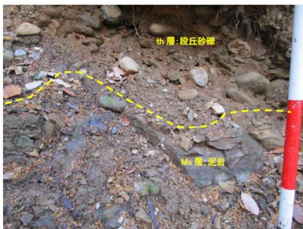
写真-1 泥岩層と段丘砂礫層の境界
