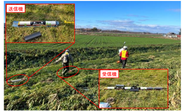
図-1 牽引式電気探査の測定状況例
