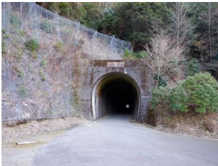
写真-1 起点坑口
