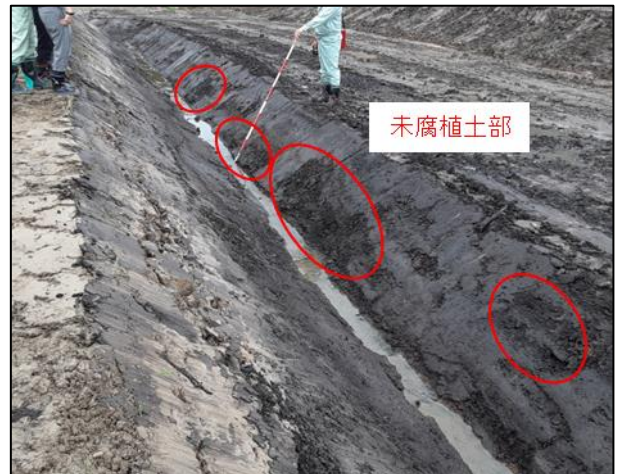
写真-3 すべり発生後の水路断面における不均質な腐植土
