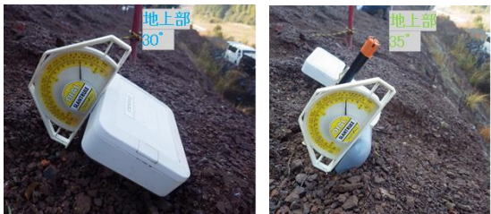
写真-3 変状状況(左:機器A、右:機器B)
