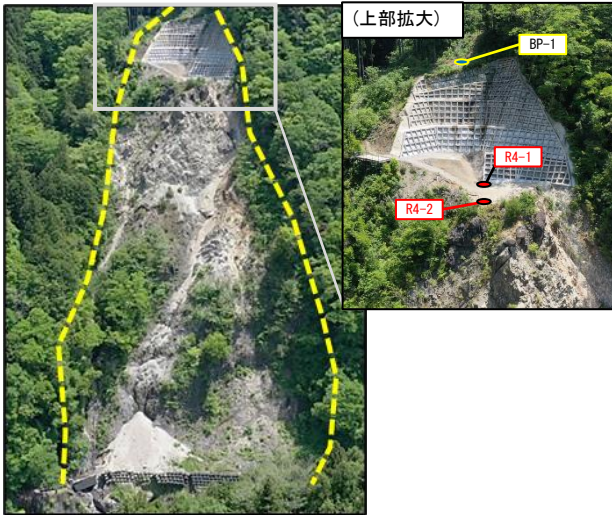
写真-1 崩壊斜面全景 (R5.5 撮影)
