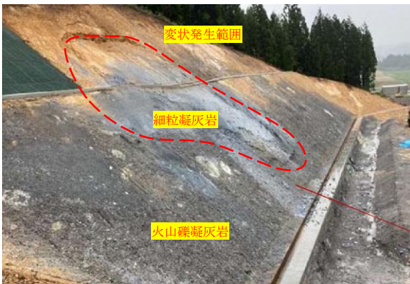
写真-1 崩壊発生前ののり面状況
