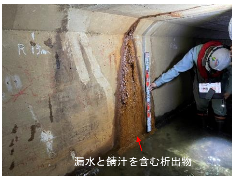
図-1 目視点検時状況写真
