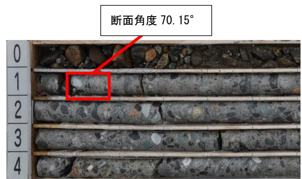
写真-3 VB-3地点 (A1橋台付近) のボーリングコア
