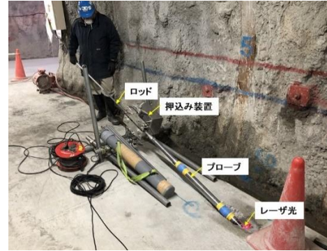
写真-1 測定状況写真
