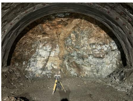
図-5 坑口から 230m の切羽写真
