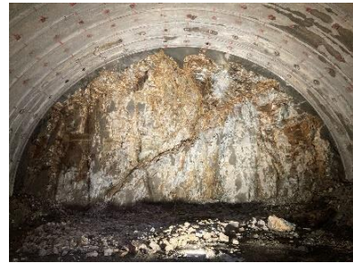
図-3 坑口から140mの切羽写真
