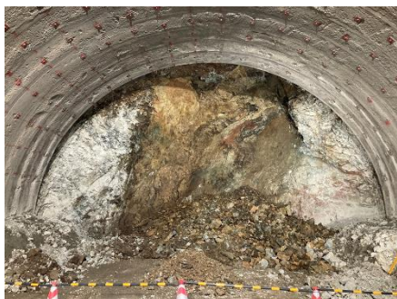
図-4 坑口から 178m の切羽写真
