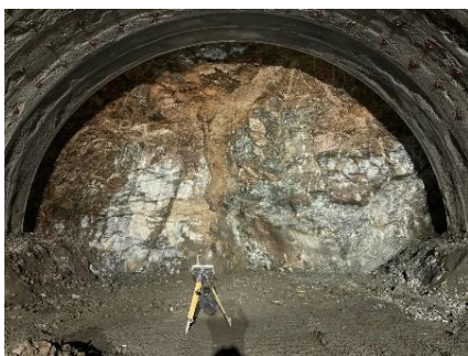
図-5 坑口から 230m の切羽写真
