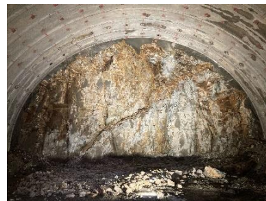
図-3 坑口から140mの切羽写真
