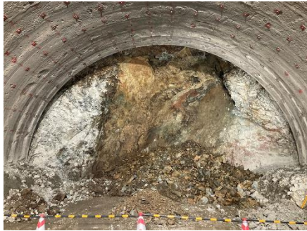
図-4 坑口から 178m の切羽写真
