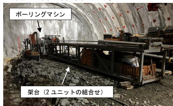
写真-2 ボーリング架台
