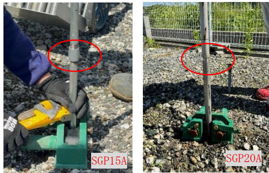
図-4 水位測定管の設置状況
