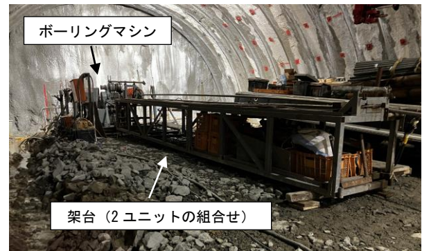
写真-2 ボーリング架台
