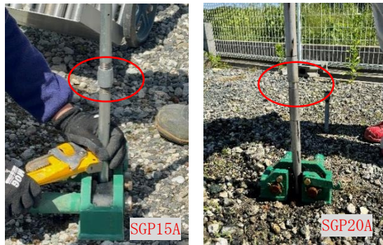
図-4 水位測定管の設置状況
