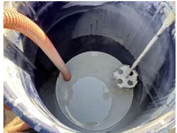
写真-2 現場での作泥の様子
