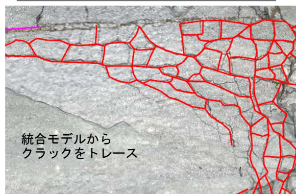
図-6 クラックのトレース(踏査結果統合モデル)
