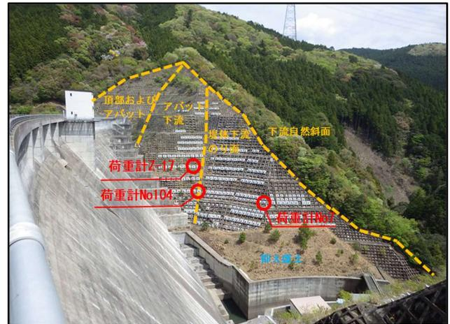
図-2.アンカー荷重計位置図
