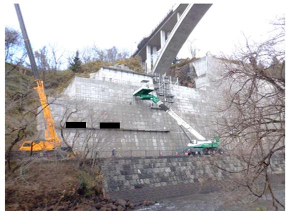
図-8 PCW 工法施工状況
