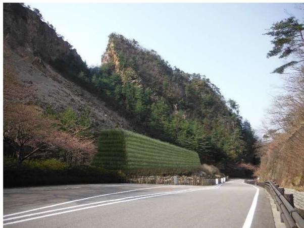
図-5 落石防護補強土擁壁のイメージパース
