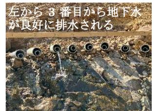
写真-1 横ボーリング孔の排水状況
