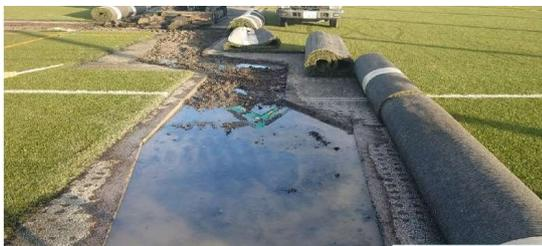
写真-2 人工芝直下の地下水の滞留
