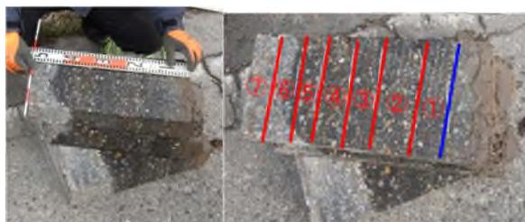
図-5. 舗装厚の確認状況
