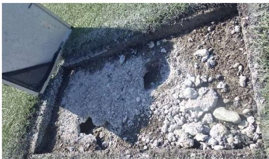
写真-3 再生路盤材の固結および空洞
