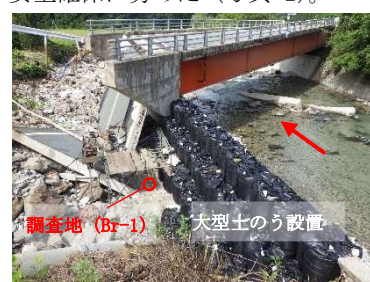
写真-2 調査時のA2橋台周辺の状況
