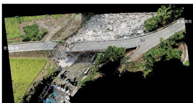
図-5 UAV 調査の三次元点群データ切出画像（桁上部）
