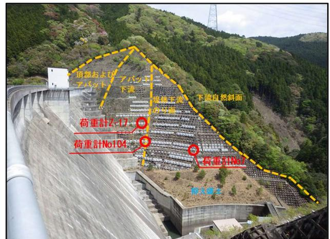
図-2.アンカー荷重計位置図
