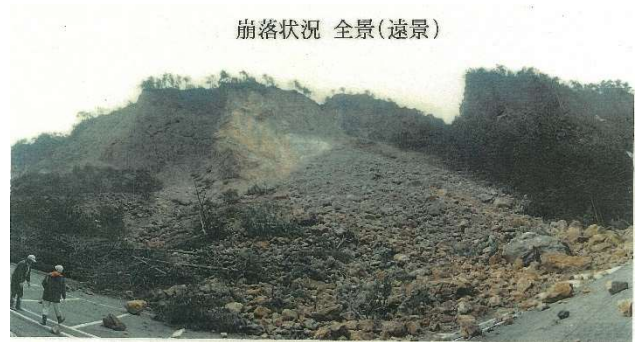
図-2 平成 23 年に発生した落石災害の状況
