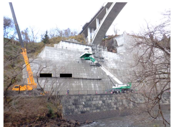
図-8 PCW 工法施工状況
