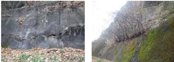
写真-1 開口亀裂20~30mm 写真-2 苔や植生の繁茂状況
