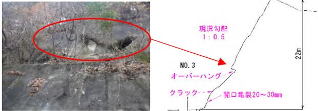
写真-3 オーバーハング部状況 図-1 横断面図(NO.3)
