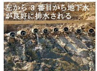
写真-1 横ボーリング孔の排水状況
