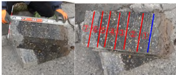
図-5. 舗装厚の確認状況
