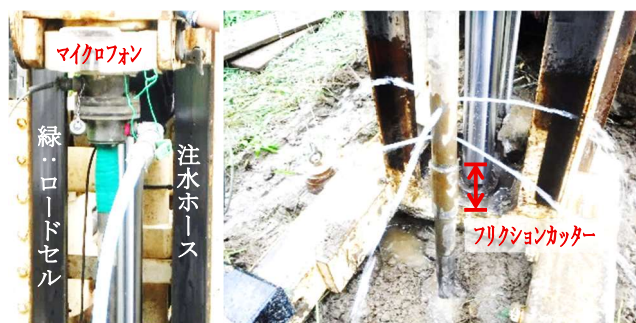
図-1 注水マイクロフォンと清水吐出状況(6ℓ/min)
