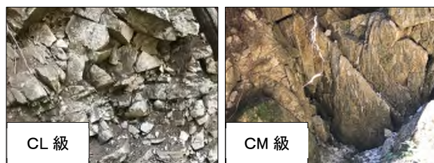
写真-1 花崗岩(地山)の割れ目の状況
