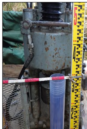
図-5 PVC 塩ビ管挿入（近景）
