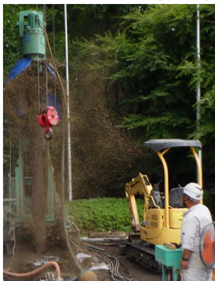
写真-1 さく井工事(ダウンザホールハンマ工法)の懸濁水発生状況
