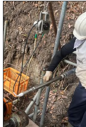
図-7 水平孔の撮影状況
