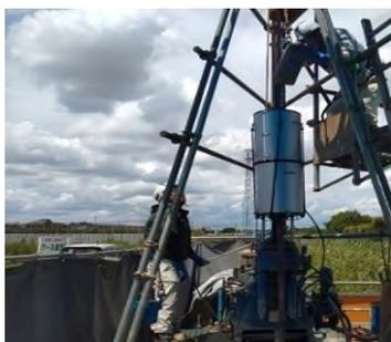
図-4 減音ボックスの取付け状況
