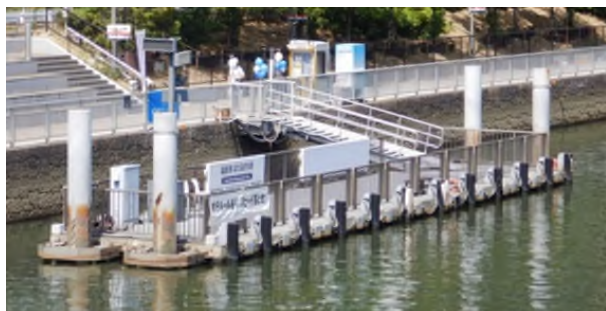
図-1 防災船着場（浮桟橋）
