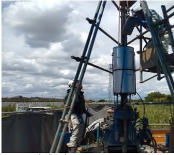
図-4 減音ボックスの取付け状況
