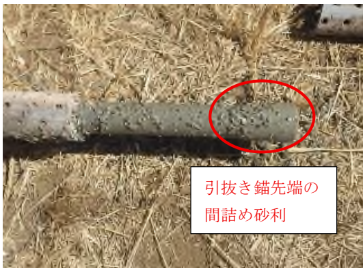
写真-4 引抜き錨先端の間詰め砂利
