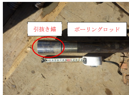
写真-3 引抜き錨装着状況
