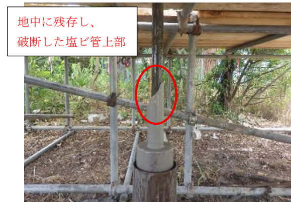
写真-5 残存した塩ビ管の引き上げ状況
