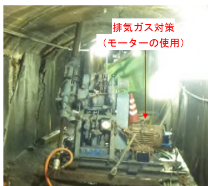
写真-1 閉鎖空間（ダム監査廊内）での調査状況写真
