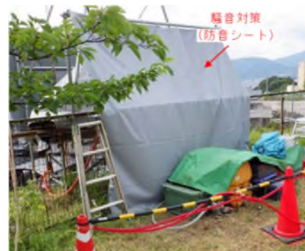
写真-2 住宅地での調査状況写真
