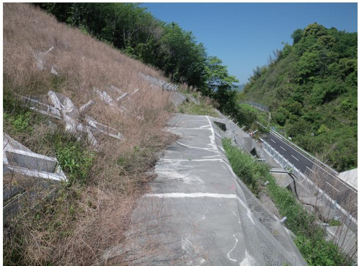
約 40m、長さ約 50m 規模の岩盤地すべりが発生
