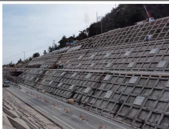
写真-3 H23年右側法面對策施工状況
