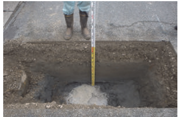
写真-1 対象地周辺の表層部に分布する細砂層の掘削例（ボーリング発生）
