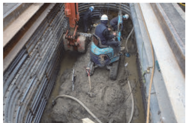
写真-2 対象地周辺の施工事例
