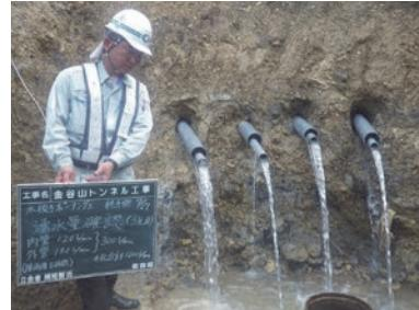
図 9 横ボーリング工排水状況
