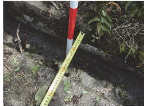
写真1 押出によりU字溝が潰れている。
