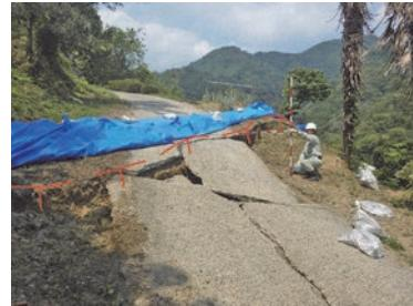
右側方部のクラック・沈下
