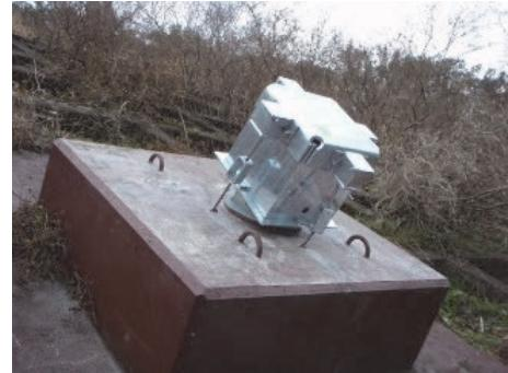
写真 2 アンカー飛び出し防護工設置状況
