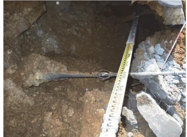
写真・3 鉄筋挿入工部の中抜け被災
