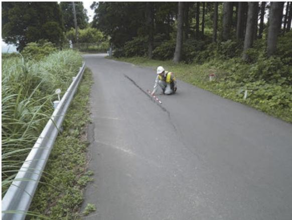
写2. 排土法面背後の路面に発生した亀裂
