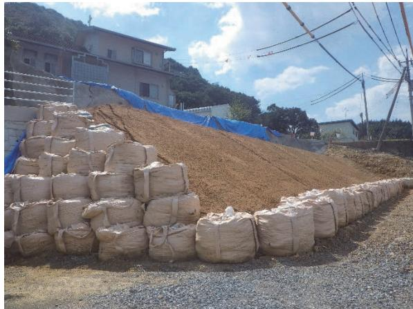
写真・4 押え盛土工施工状況
