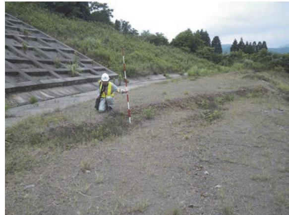
写3. 掘削エリアに発生した段差
