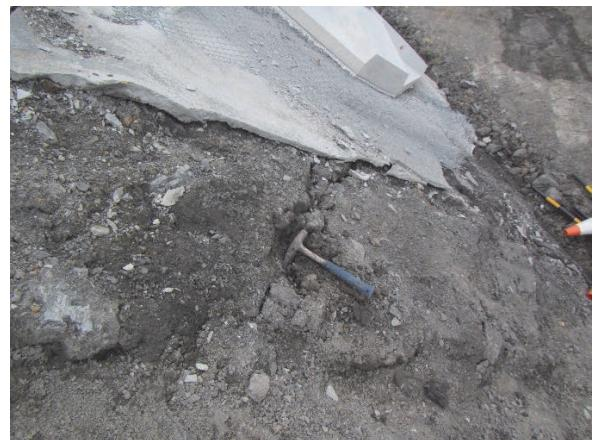
写5. 掘削法面の状況（含水による軟弱化）
