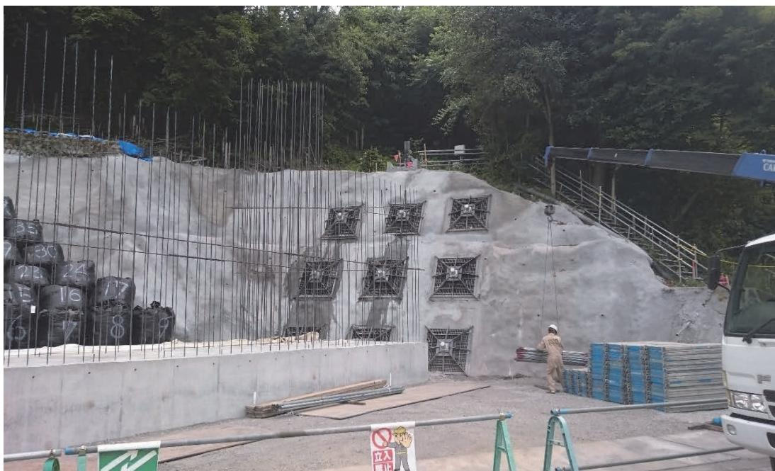
図 8 斜面安定工完了状況
