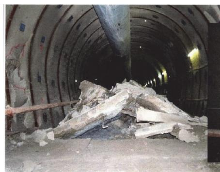
写真1 I期線トンネル掘削後の盤膨れの状況
