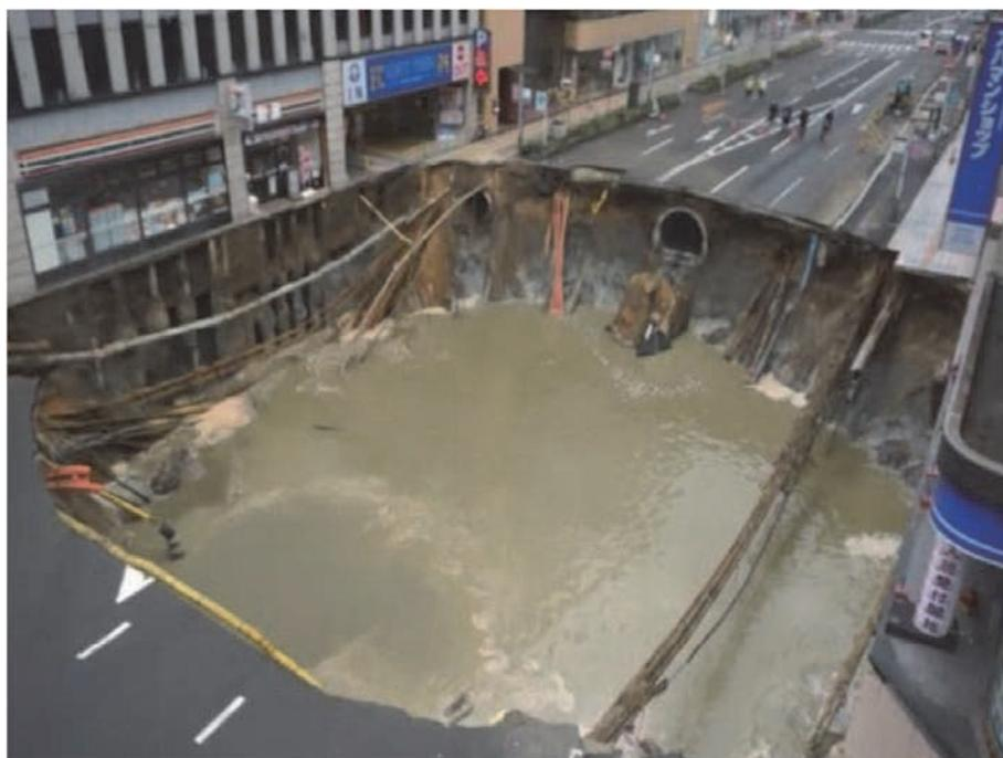
図1-3 地下鉄工事によって発生した駅前の陥没事故<sup>2)</sup>
