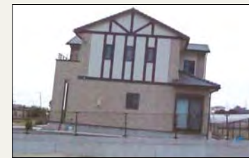
図1 基礎地盤が液状化したために沈下した家屋(茨城県神栖市)
